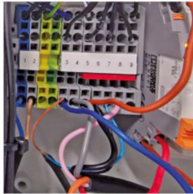
**9.** Stellantrieb und Unterdruckdose mit Regelung verkabeln (siehe Klemmplan)
