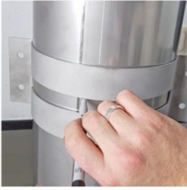
**1.** Die Halbschale mit dem Schlitz dient zur markierung der Einbauöffnung an ein vorhandenes Abgassystem
