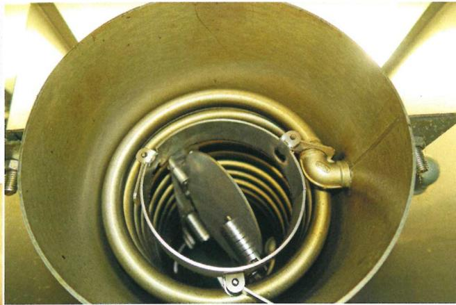
Einblick in die Wärmeübertrager. Die bimetallegeregelten Leitbleche lenken die heiße Luft mehrfach um und führen diese an die mit Heizungswasser gefüllte Rohrschlange vorbei, die den Heizungswasserpufferspeicher mit Wärme versorgt.
