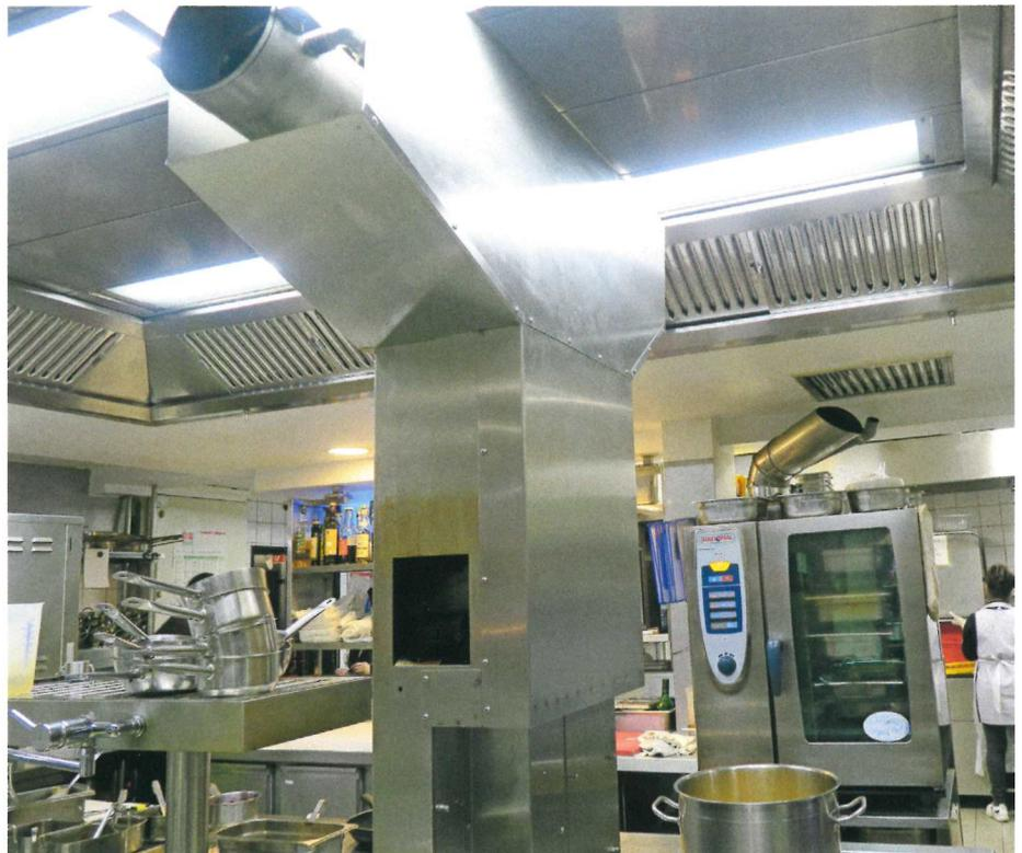
Vier in einem: In die Haubenkonstruktion sind vier Wärmeübertrager des Typs „TurbuflexS-300“ integriert. Die abgekühlte Luft wird über die Esse in das Abluftsystem geleitet.
